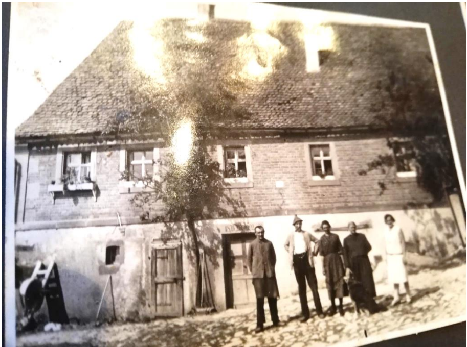
Die Mühle in den 1930-er Jahren
